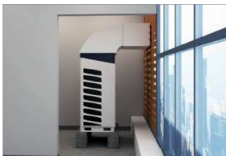
Installation des Kanals
